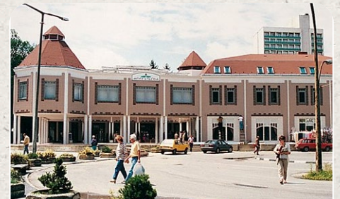
Aparthotel Hévíz MAĎARSKO / štúdio 2/3/4 lôžka
